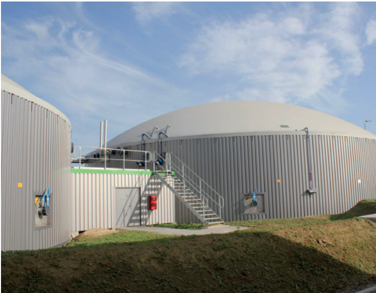
Vergistingsinstallatie van Biopower, Tongeren.
